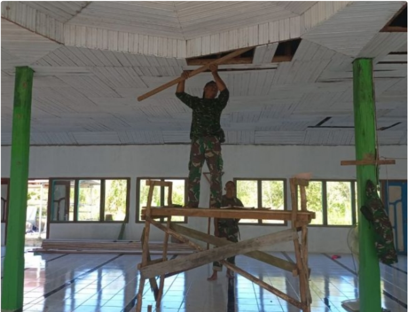
Satgas TMMD ke-113 Kodim 1005/Barito Kuala Pasang Plafon Masjid
